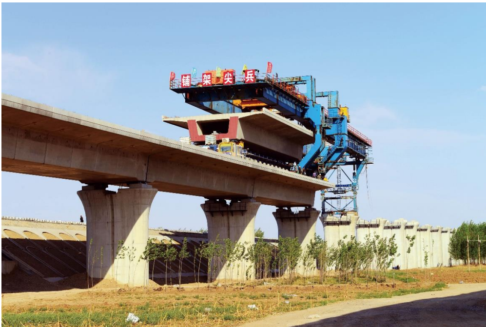
Exempel multi-wheeler transportör och broläggare (CRIG)
