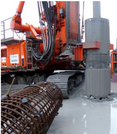
Typisk borr-rigg och armering för påle
