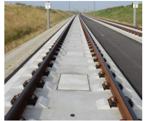
Från Slab Track Austria
