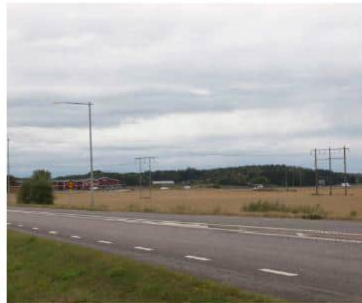
Vy norrut över åkerlandskapet vid Skälv. Vägen mot Norrköping syns i förgrunden och E4 i bakgrunden.
