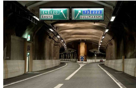
Ex: Infästning av vägg med dörr för nödutrymningsväg.
